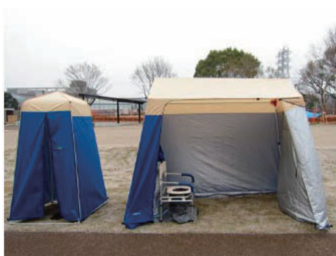
マンホールトイレ(野田中央公園)
