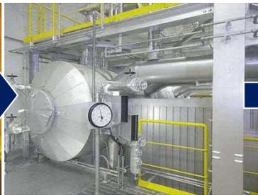
この熱をボイラー内部の水と熱交換して、高温高压の蒸気をつくります。
