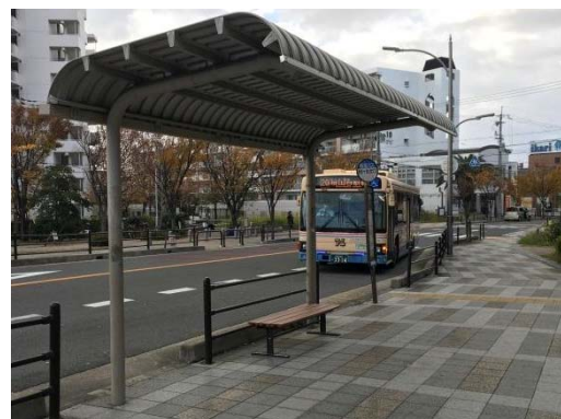
図 2.57 バス停ベンチ設置状況(旭ヶ丘北口バス停)
