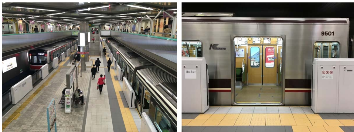
図 2.58 可動式ホーム柵設置状況（北大阪急行電鉄千里中央駅）
