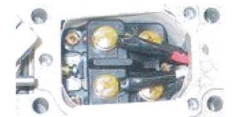
内部に浸水していないか確認
