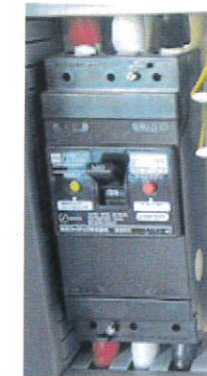
③1次側の電源ブレーカーを投入します
