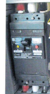
①1次側の電源ブレーカーを遮断します
