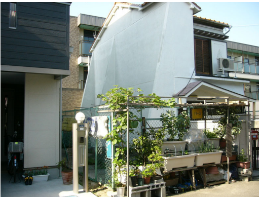
隣家の支え壁がある移転跡地②
