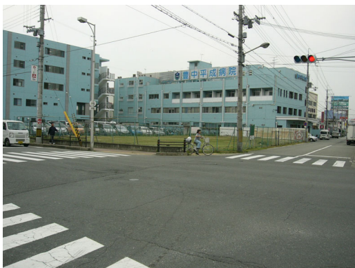
幹線道路に面した移転跡地②
