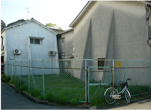
隣家の支え壁がある移転跡地①
