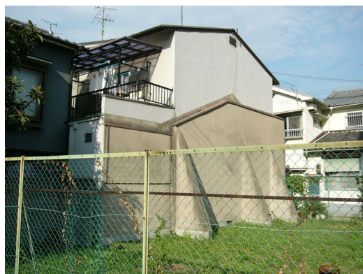
隣家の支え壁がある移転跡地
