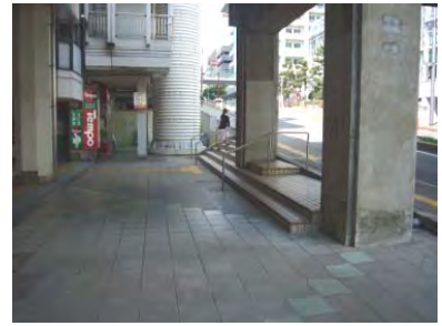
駅北出口とアクセスする部分と歩道との段差
