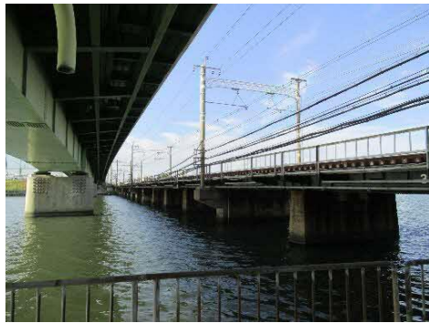
下神崎川橋梁
