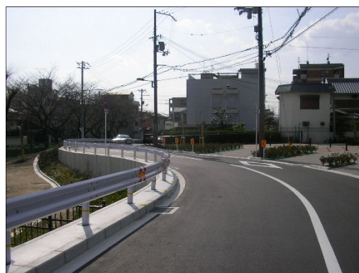
整備済み区間（庄内北回り線）
