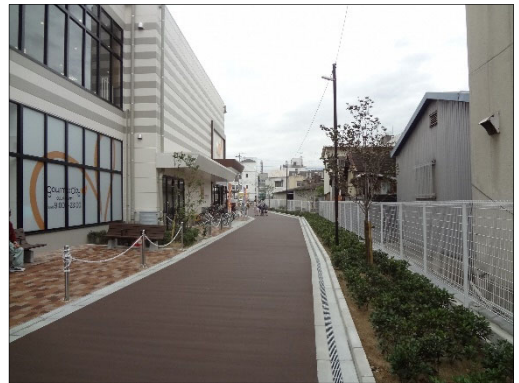
主要生活道路の整備
