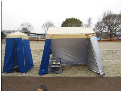
防災マンホールトイレ
