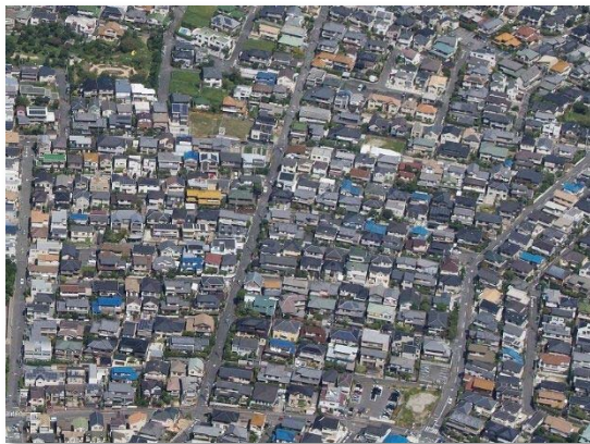
良好な低層戸建住宅が建ち並ぶ緑丘地区
