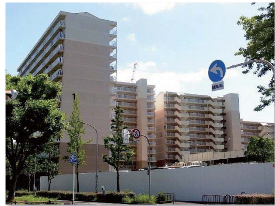
府営住宅の建替え事業が進む 新千里東住宅地区
