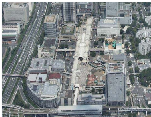
再整備が進む千里中央東地区
