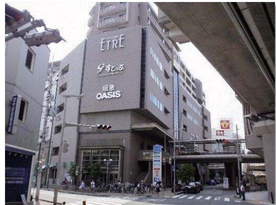
市街地再開発事業により整備された豊中駅前
