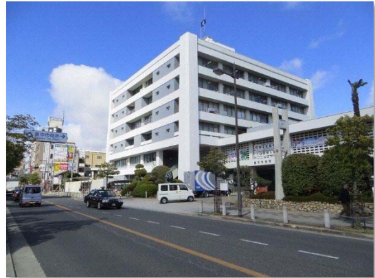
岡町駅周辺に集積する公共施設（市役所）
