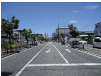
南部地域の防災ラインとして整備された穂積菰江線
