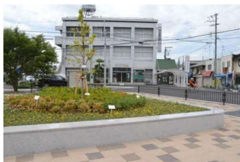
道路整備でつくられたうるおい空間（庄内幸町）
