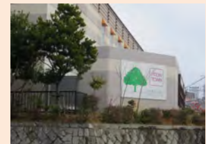
屋外設備を建築物と同じ意匠の囲いで隠している
