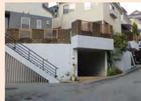
擁壁のセットバックや緑化、意匠の工夫で圧迫感を軽減している
