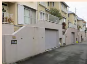
擁壁に低彩度色を用いることで、威圧感を軽減している
