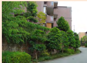
建築物外周に樹木を多層的に配し、潤いを高めている
