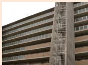
屋外階段をルーバーで覆い、建築物になじませている
