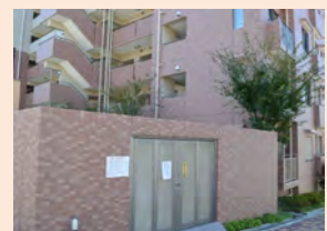
ごみ置き場を外壁色と一体的な意匠とし、目立たなくしている
