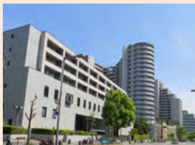
横ラインに連続性が感じられるファサードで、まとまりのあるまちなみにしている
