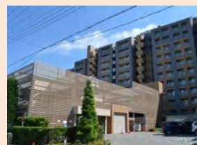
立体駐車場をルーバーで囲い、緑化も施し、威圧感を軽減させている
