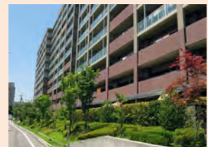
道路に面して法面を設けて緑化を施し、圧迫感を低減させている
