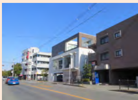
落ち着いた外壁色を用い、周囲の建築物と調和させている
