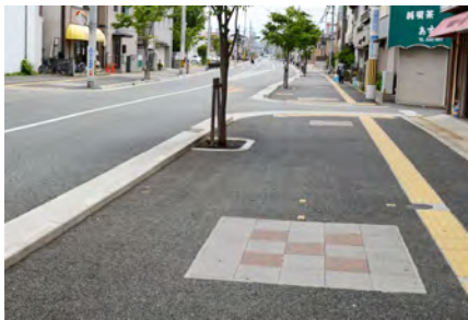
セミフラットタイプの歩道 <穂積菰江線：庄内西町>
