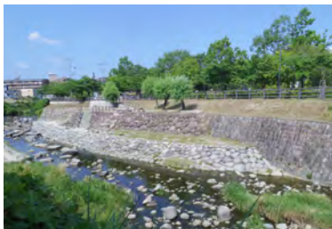
自然石を用いるとともに水辺に近づける工夫がなされた護岸 ＜千里川：向丘・春日町＞
