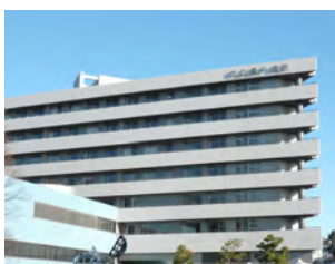
バルコニーの出を深くすると窓面が汚れにくい <市立豊中病院：柴原町>
