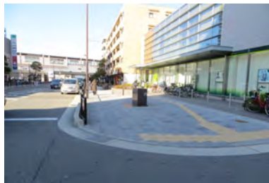
目地の狭い平滑で歩きやすい平板舗装 <曾根東町>
