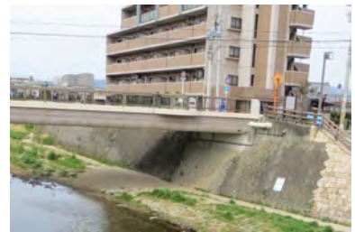
橋梁と水管が一体の意匠 ＜千里川：箕輪＞
