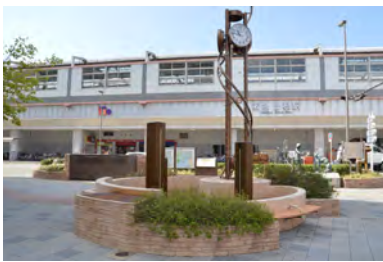
舗装や構造物、駅舎の色彩を調和させ一体感を持たせている <曾根駅>
