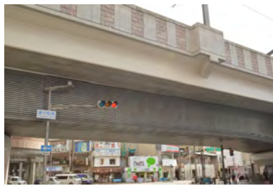
桁裏をすっきりと見せるルーバー <豊中駅>
