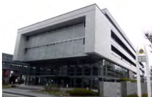
材質の色彩をいかし、モザイク状の意匠にすると、壁面の部分的な補修をしても目立ちにくい <市役所第2庁舎：中桜塚>
