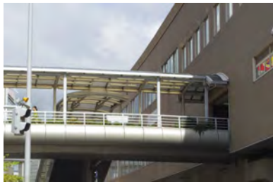
視線が桁裏に留まらないようにするパネルの覆い ＜豊中駅＞
